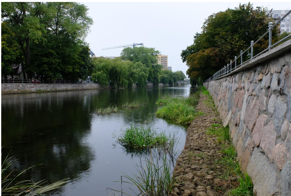
Zdjęcie 3.1. Parsęta w m. Kolobrzeg – przykład umocnienia skarp (autor: K.Gruca)
