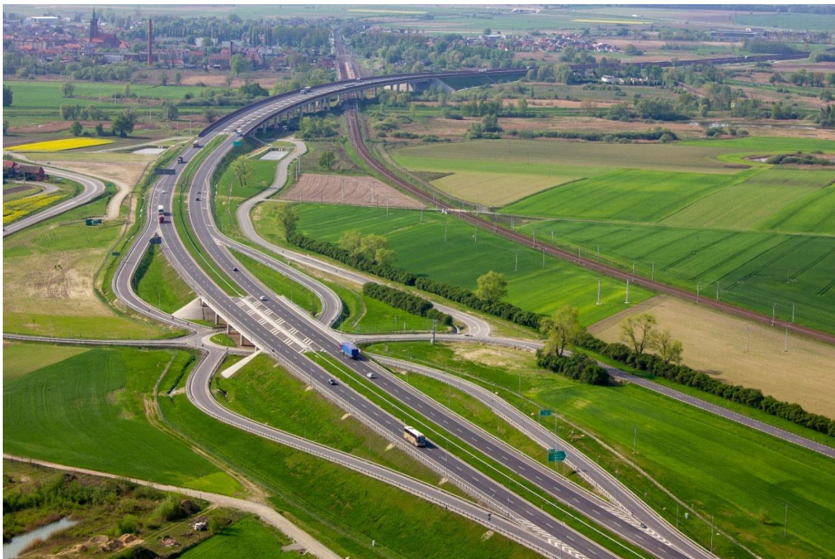
Fotografia 6.1. Nowo wybudowana droga w ciągu drogi krajowej S5 – Węzeł Żmigródek (fot. Władysław Kluczewski)
