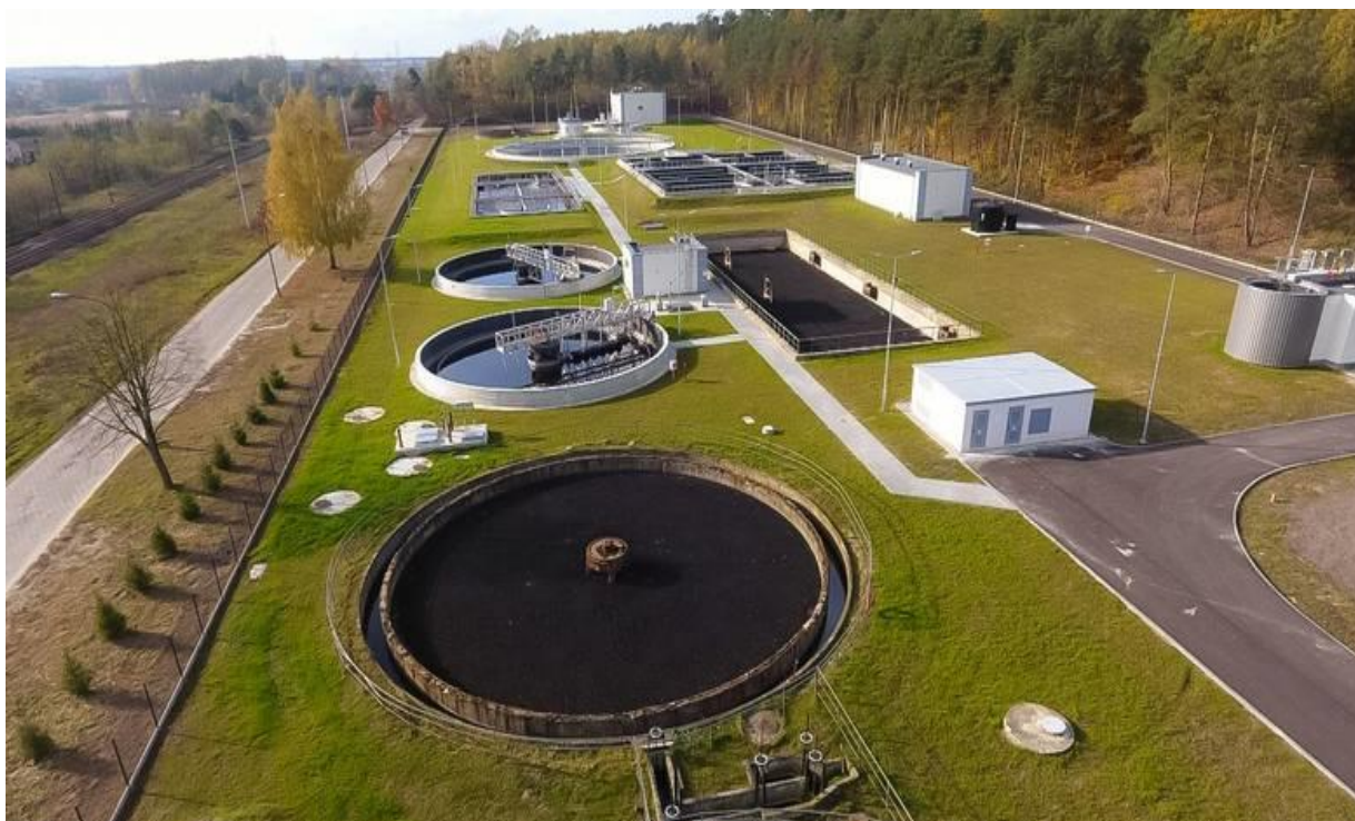
Fot. 3.3. Oczyszczalnia ścieków w Pionkach (źródło: WIOŚ)
