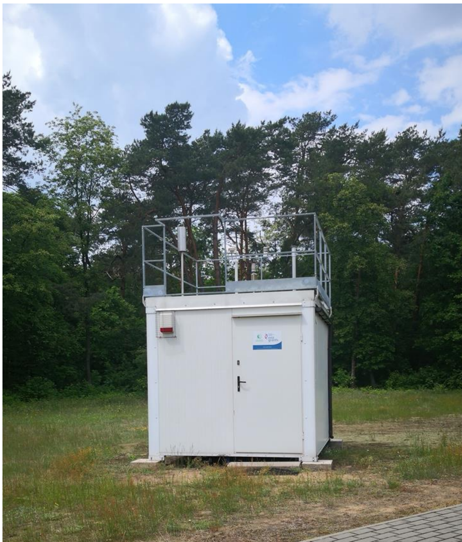
Fot. 2.1. Stacja pomiarowa w Otwocku, przy ul. Brzozowej (źródło: GIOŚ)
