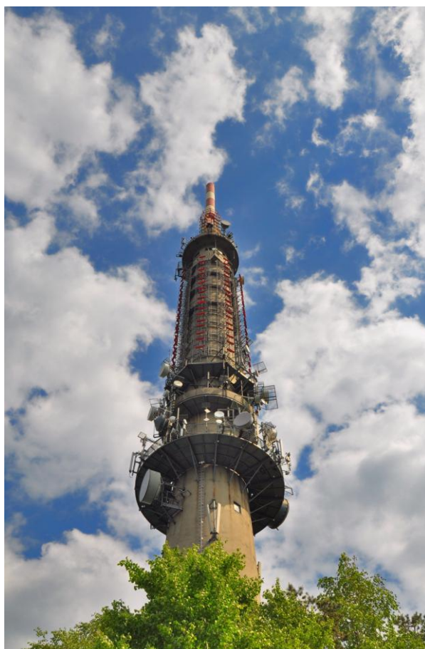
Rys.3.2.1 Sucha Góra. Radiowo-Telewizyjne Centrum Nadawcze. Anteny na betonowo-stalowej konstrukcji wsporczej. Fot. Stefan Różycki
