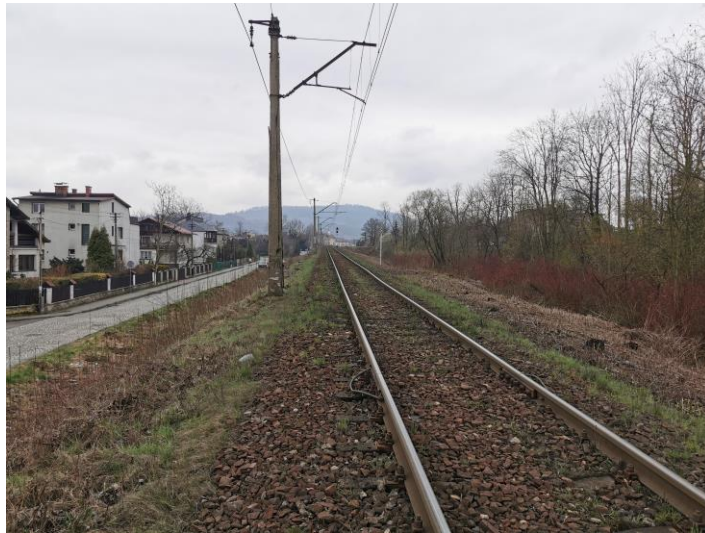
Fot. 3. Żywiec, RB1. Linia kolejowa nr 139 w kierunku dworca kolejowego w Żywcu.
