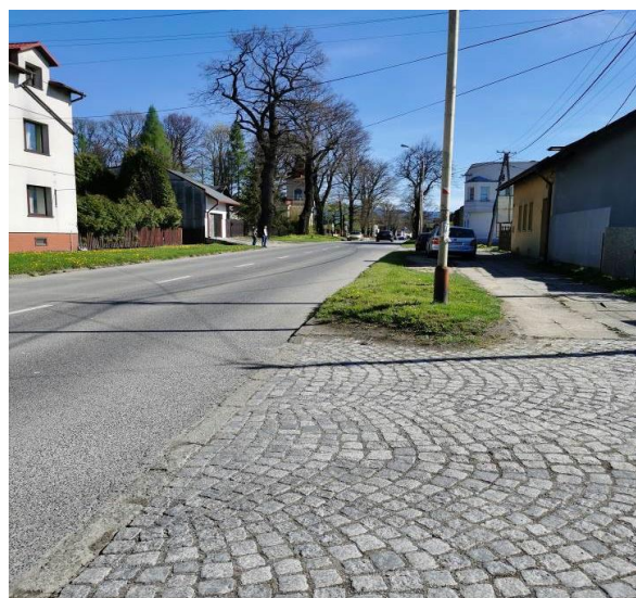
Fot. 3. Żywiec, RB2. Badany odcinek ul. Sienkiewicza w kierunku skrzyżowania z ul. Żeromskiego.
