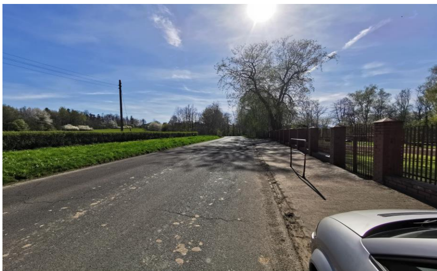
Fot. 7. Żywiec, RB4. Badany odcinek ul. Moszczenickiej w kierunku ul. Wichrowej.
