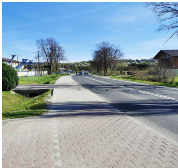
Fot. 2. Żywiec, RB1. Badany odcinek ul. Krakowskiej w kierunku skrzyżowania z ul. Ślemieńską.
