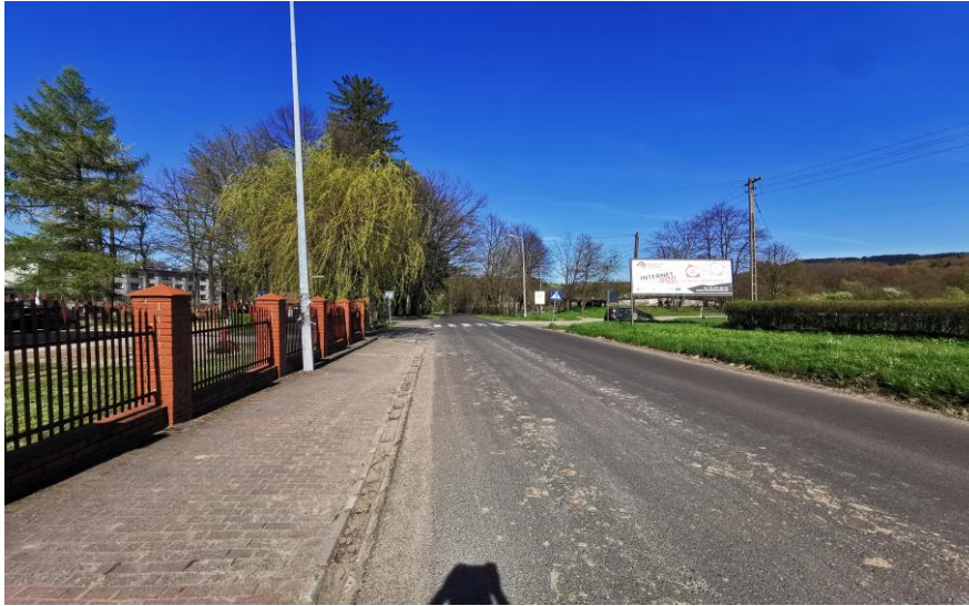
Fot. 8. Żywiec, RB4. Badany odcinek ul. Moszczenickiej w kierunku ul. Rychwałdzkiej.
