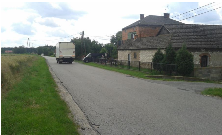
Fot. 15. Jeziorowice, RB5. Badany odcinek drogi w kierunku Otoli.
