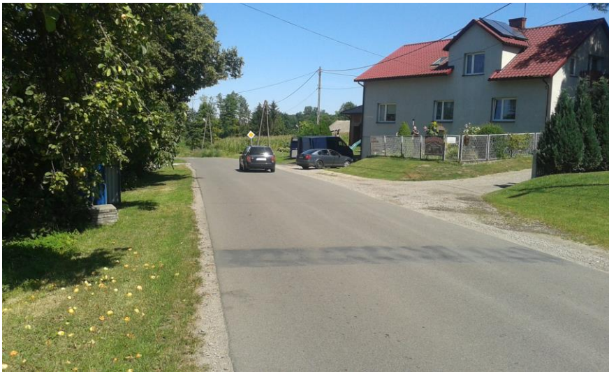
Fot. 11. Łany Wielkie, RB4. Badany odcinek drogi w kierunku Brzezina.
