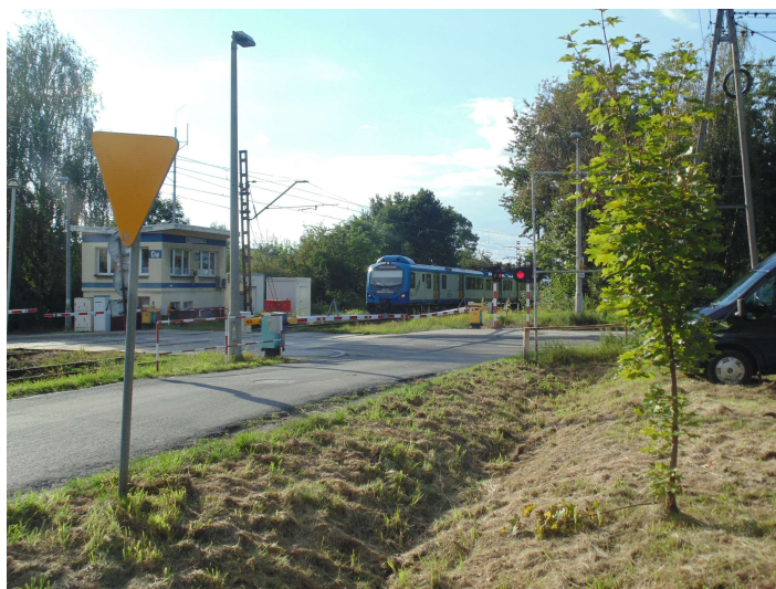
Fot. 3. Czerwionka-Leszczyny, RB1. Linia kolejowa nr 140 w kierunku dworca kolejowego Czerwionka Dębieńsko.
