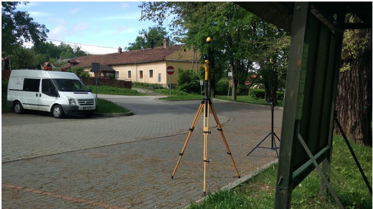
Fot. 2. Rejon badań, widok w kierunku południowo-zachodnim
