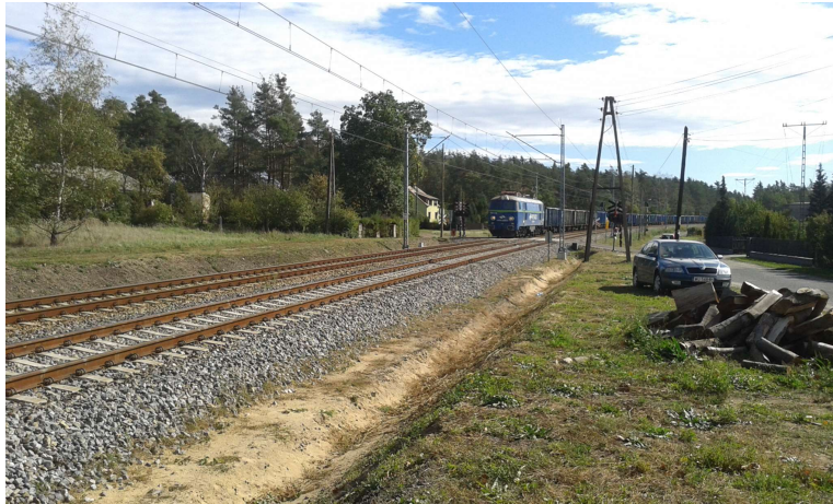
Fot. 2. Nędza, RB1. Linia kolejowa nr 140 w kierunku Rybnika.
