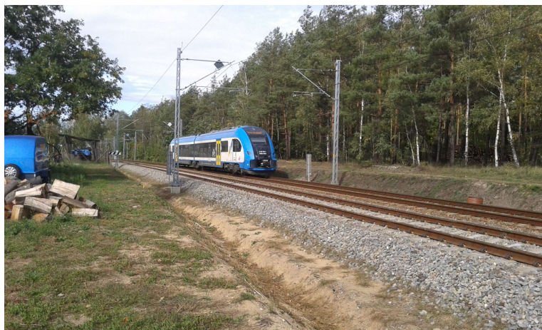
Fot. 3. Nędza, RB1. Linia kolejowa nr 140 w kierunku stacji Nędza Wieś.
