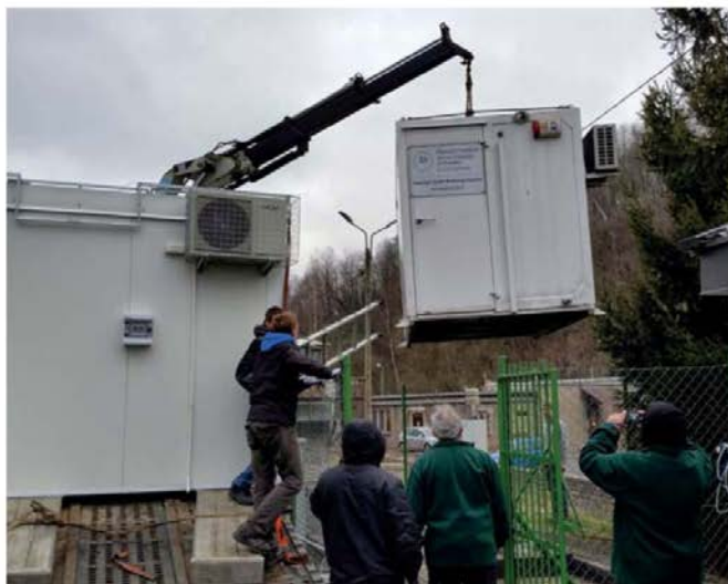
Demontaż kontenera, stacja Wałbrzych, WIOŚ Wrocław (fot. Paweł Kałafatiuk)
