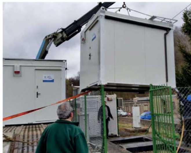
Instalacja nowego kontenera, stacja Wałbrzych, WIOŚ Wrocław (fot. Paweł Kałafatiuk)
