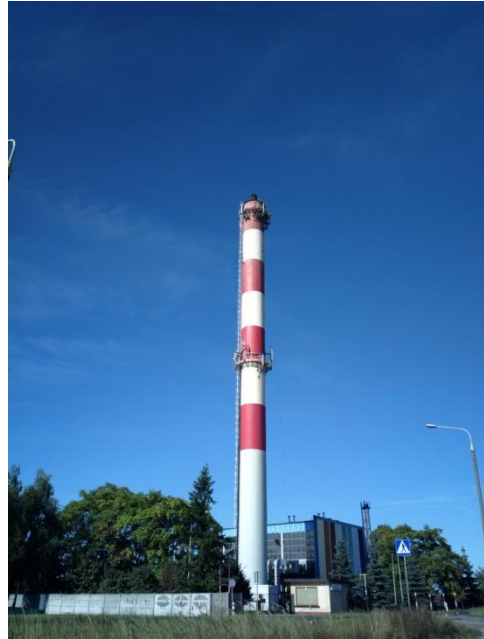
Fot. Przedsiębiorstwo Energetyki Ciepłej we Wrześni S.A. (źródło: Kamila Kmieć)
