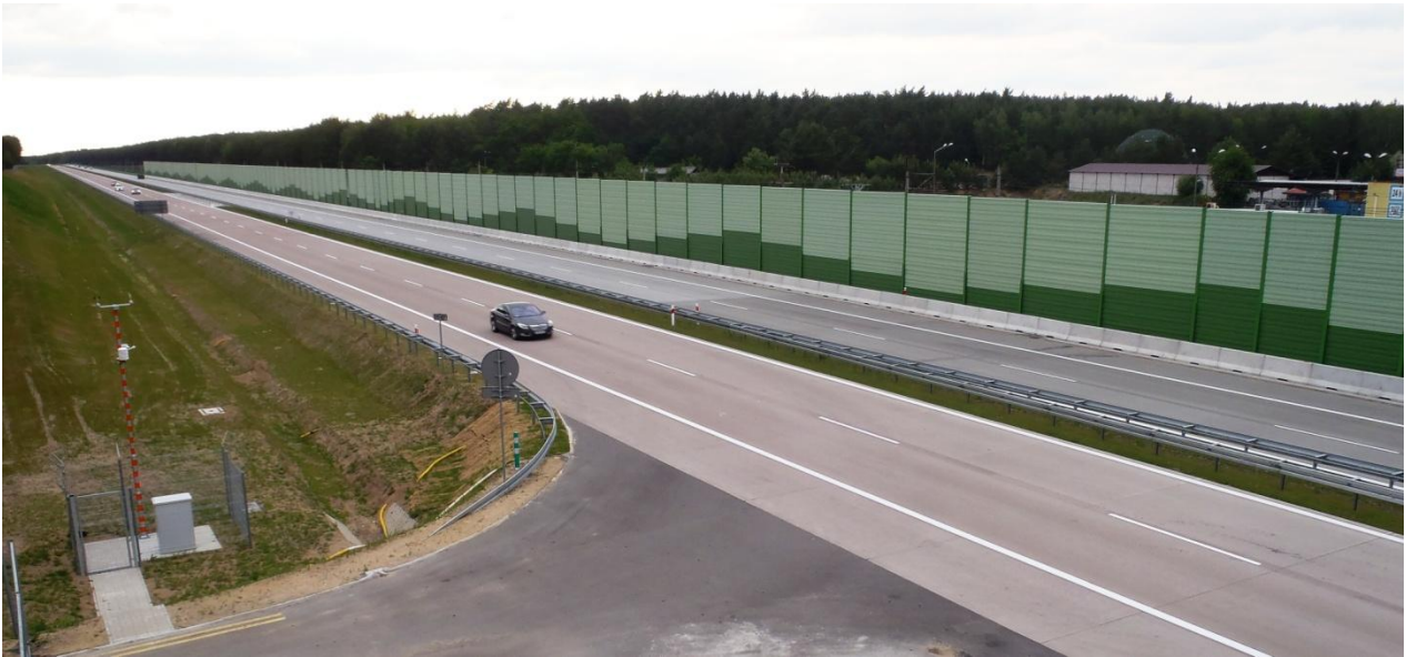
Ekran akustyczny przy autostradzie A2 koło Rzepina (fot. Przemysław Susek)
