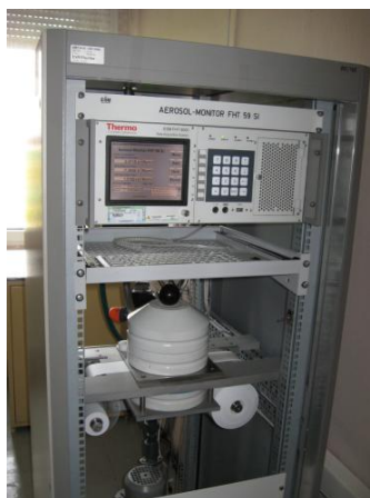
Fot. 6. Stacja aerozolowa FHT 59 Si
