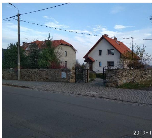
Fot. nr 15 Strzelin, ul. Staromiejska 25D
