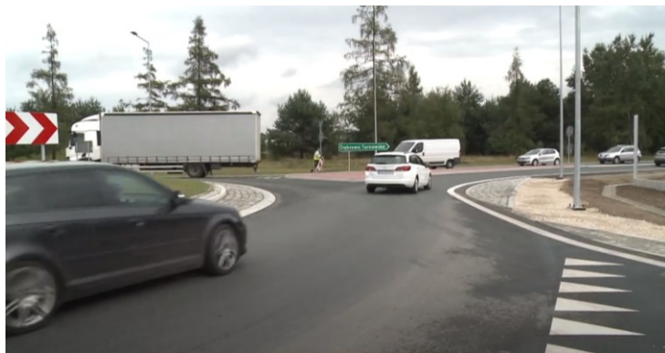
Fot. Trasa główna obwodnicy Dąbrowy Tarnowskiej w ciągu DK73 oddana w 2020 r.
