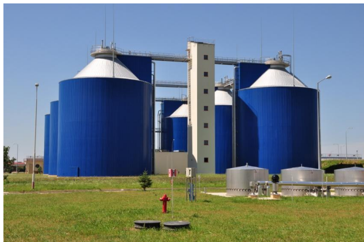
Wrocławska Oczyszczalnia Ścieków „Janówek” – Wydzielone Komory Fermentacyjne (fot. Konrad Antkowiak)
