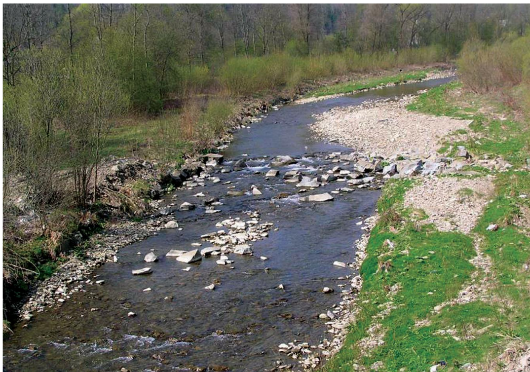
Ryc. 17 Sztuczne bystrze na potoku Krzczonówka (fot. A.Radecki-Pawlik)
